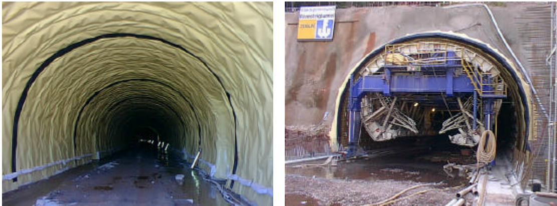
Ansichten des Rennsteigtunnels in der Bauphase
